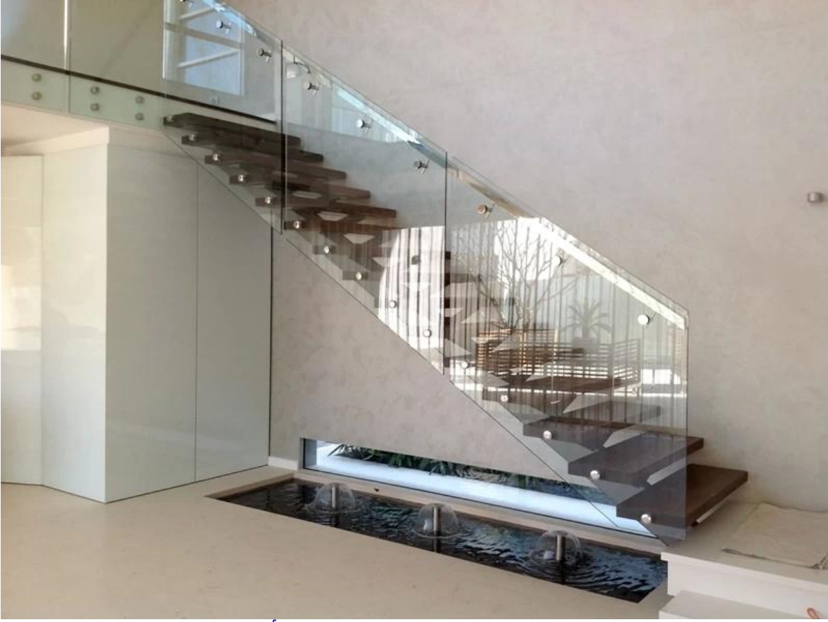
مواقد زجاجية من الفولاذ المقاوم للصدأ لدرابزين زجاجي بدون إطار
