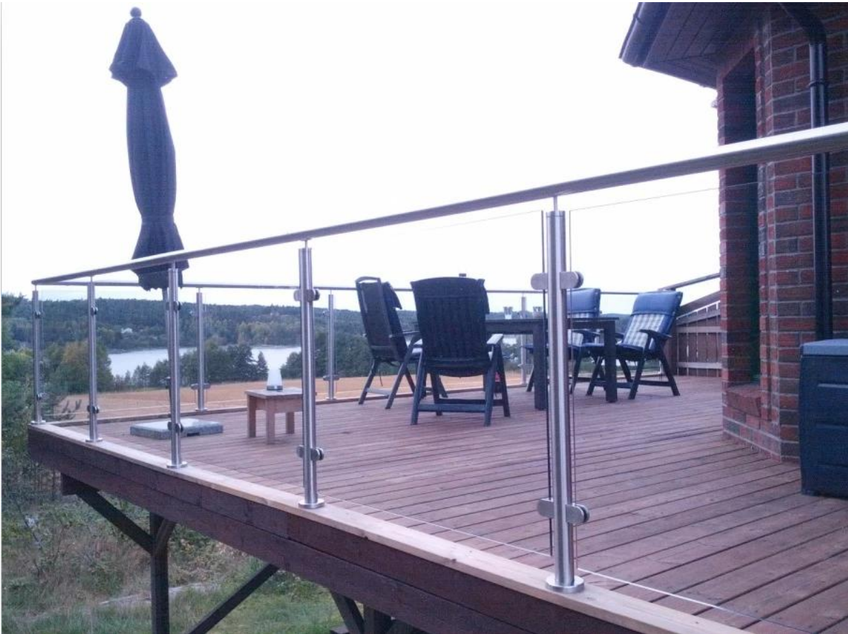
شبه الإطار في الهواء الطلق الفولاذ المقاوم للصدأ درابزين درابزين درابزين سطح الزجاج (3) تصميم
