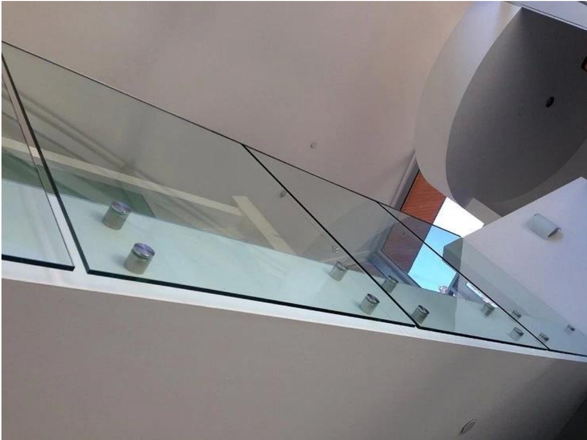
Abstandshalter aus Edelstahl, Halterung für Glasscheiben, Relingdesign
