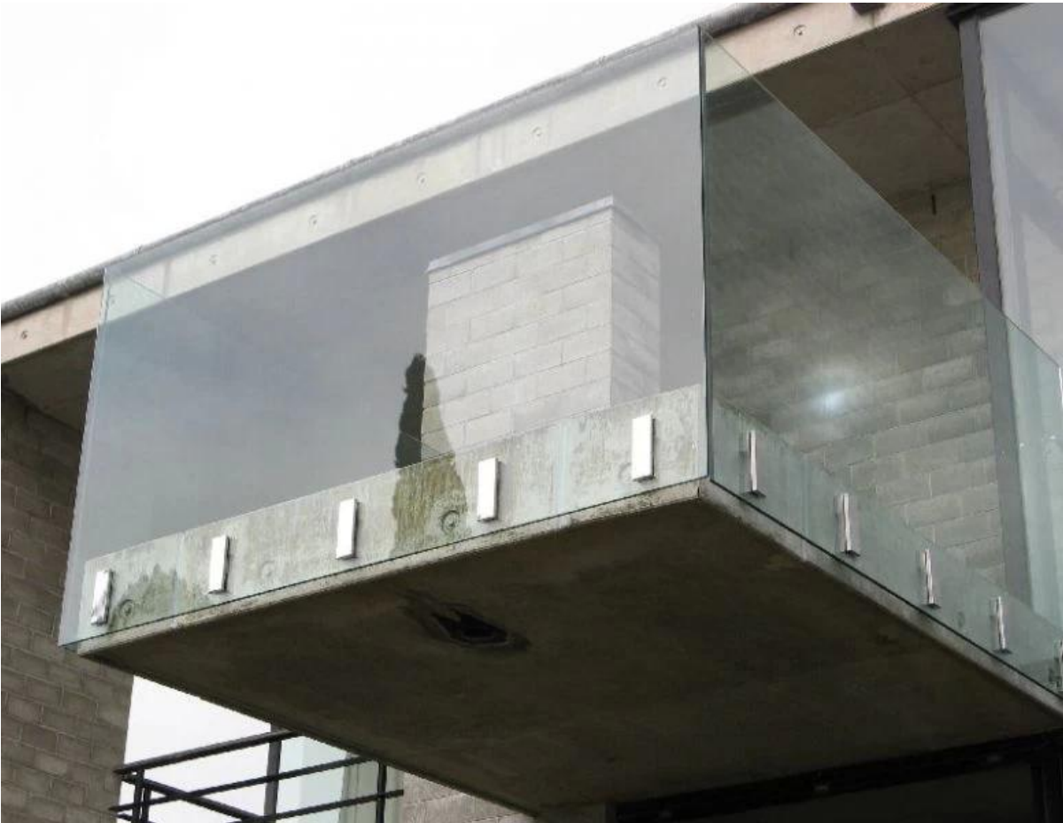
Rahmenlose Windschutzscheibenglasspannerklammer der
