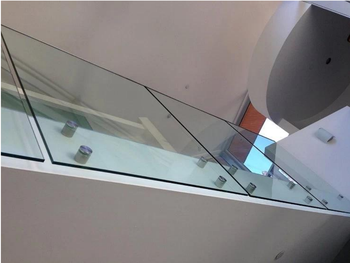
Abstandshalter aus Edelstahl für rahmenlose Glasgeländer
