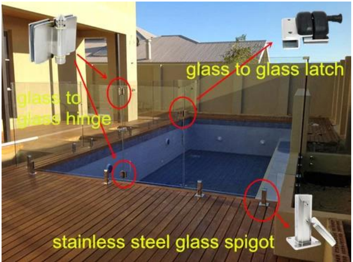
Glastürscharnier Standard-Glasplattenlöcher Positionszeichnung
