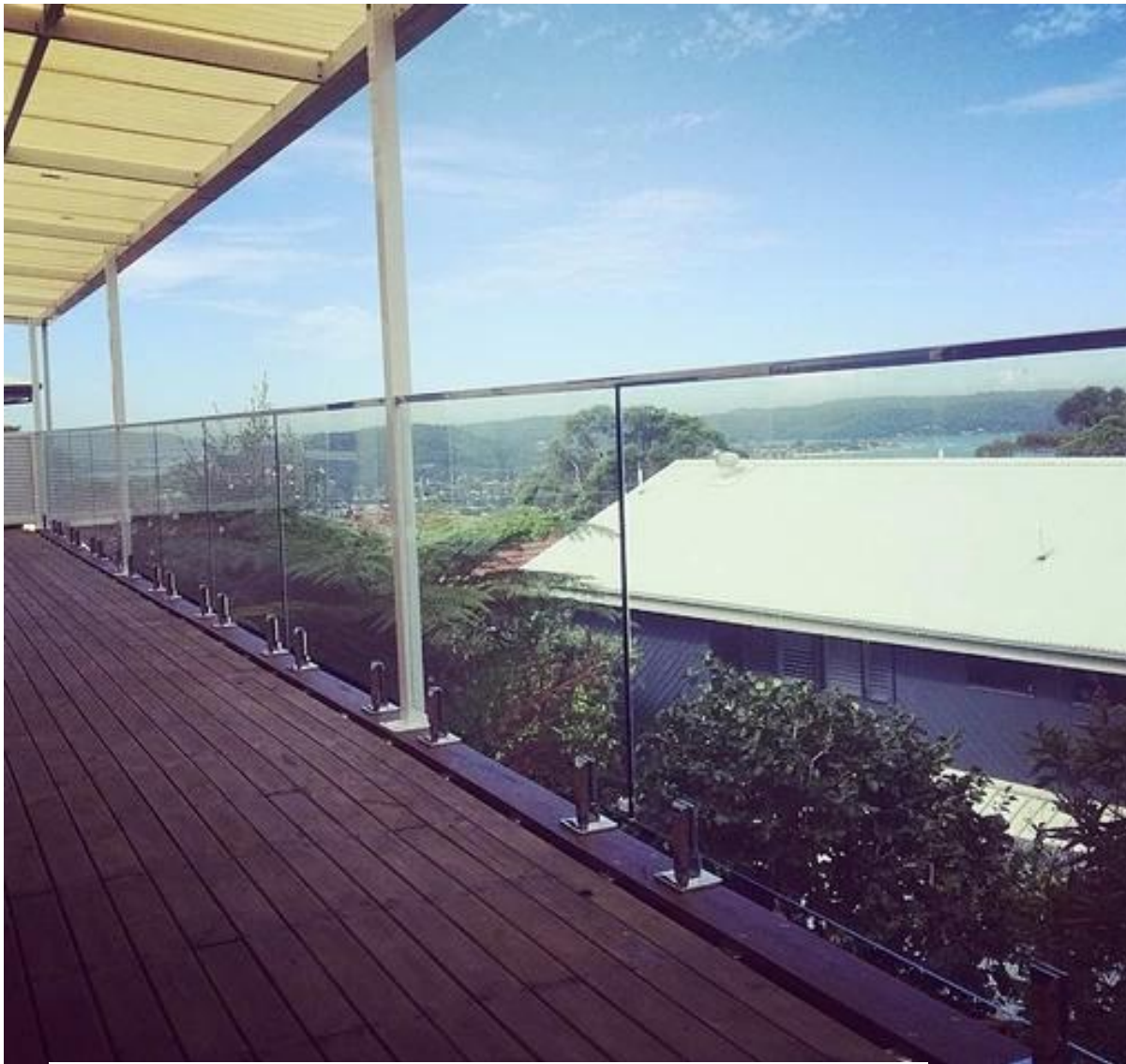
2). Handlauf aus Edelstahl Schlitzrohr Außenterrasse Glas Geländer:
