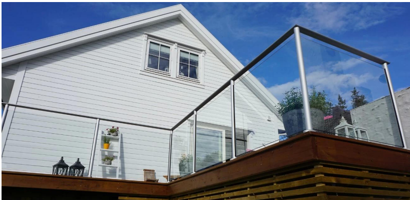
Auf der Terrasse, mit Handlauf oben
