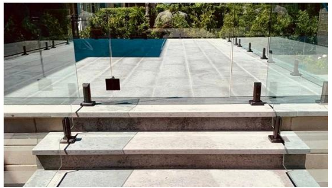
Satinado cepillado Abrazadera de vidrio con espita de acero inoxidable para barandilla de vidrio sin marco SBM-3:
