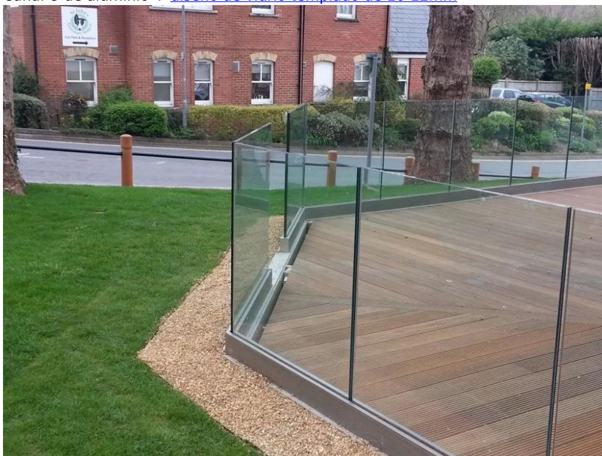
Canal U de aluminio + diseño de vidrio templado de 10-12mm
