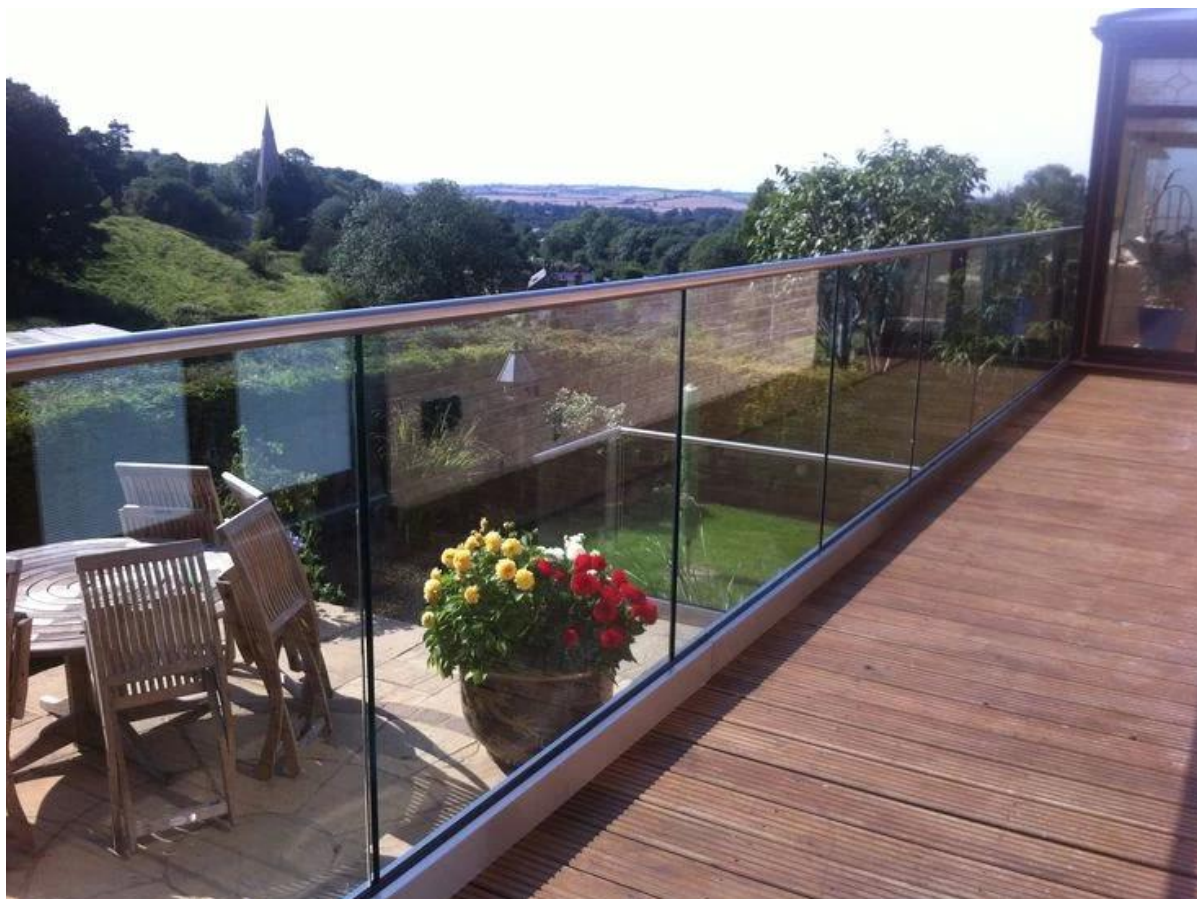
Canal U de aluminio + diseño de vidrio templado de 10-12mm
