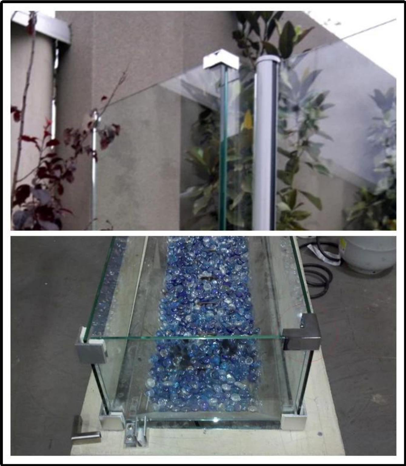
Diferentes tipos de abrazaderas de vidrio con dimensiones:
