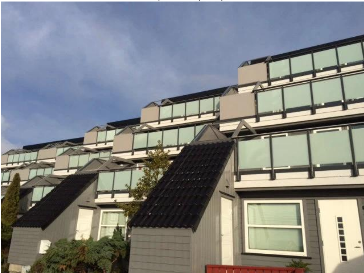
Alumiinista valmistettu sivukaiteen puomilevy Norjassa
