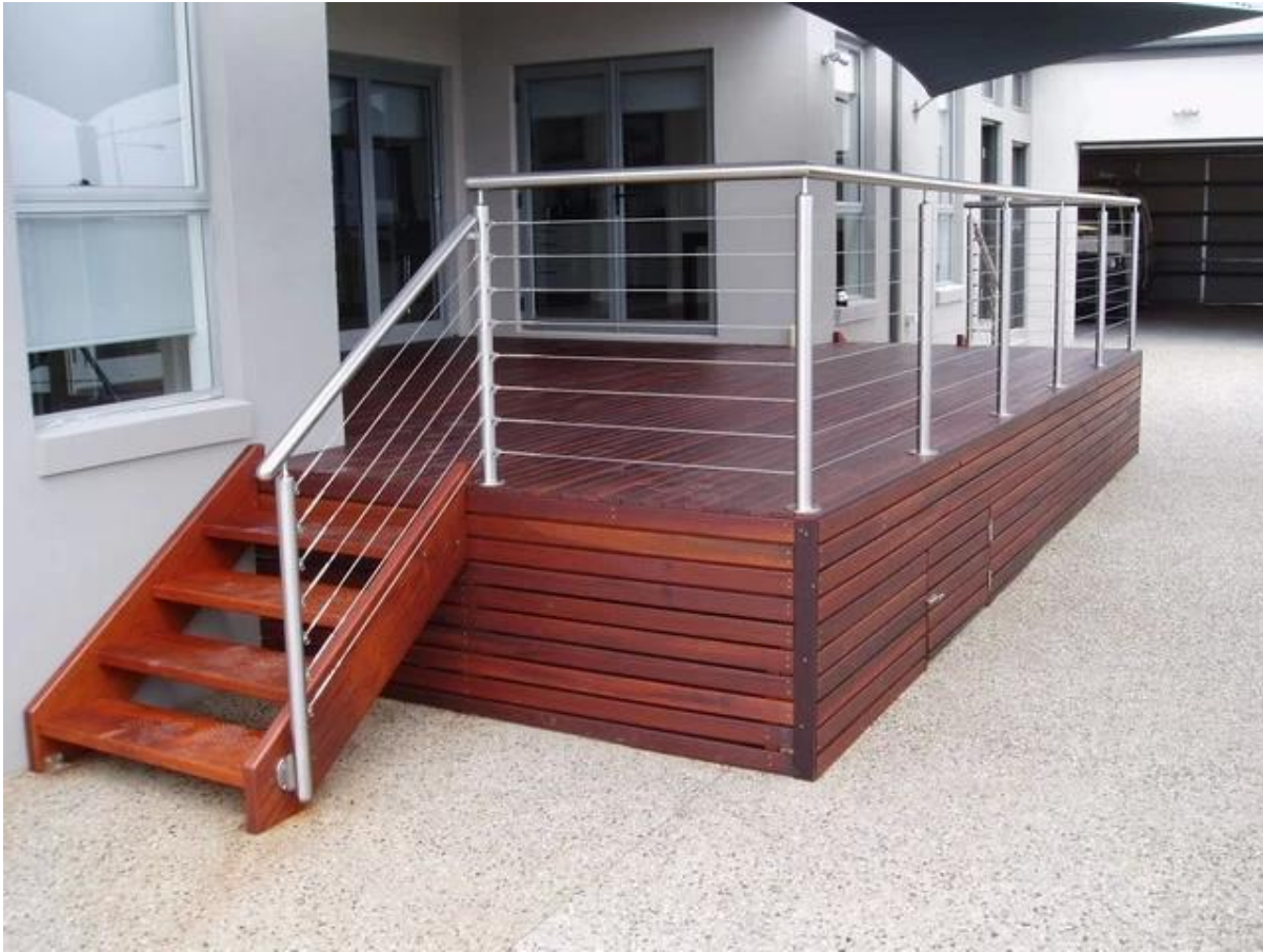
ruostumaton teräs kaapeli kaide suunnittelu sisä portaita
