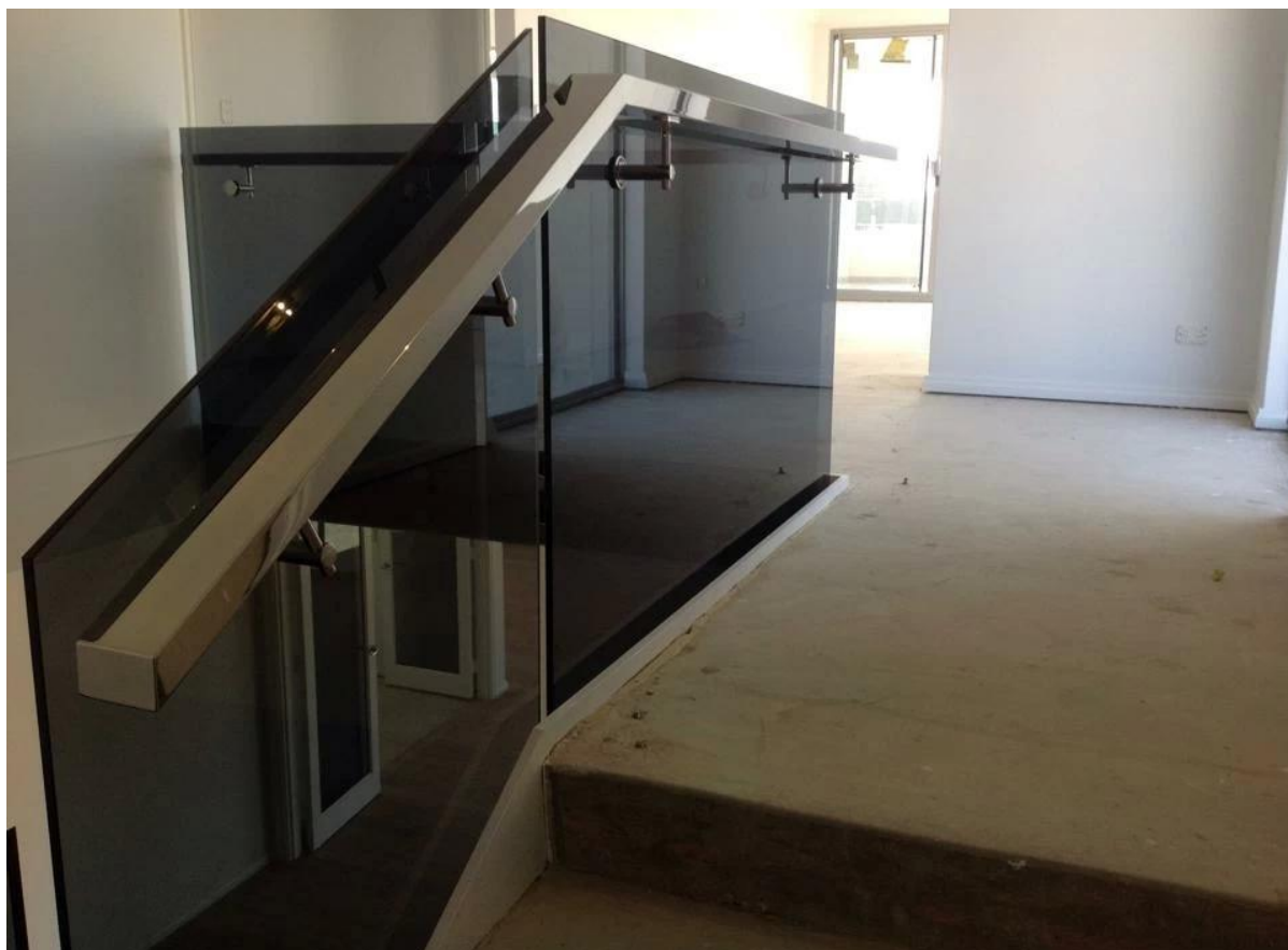
Barrière en verre trempé 12mm avec mains courantes en acier inoxydable
