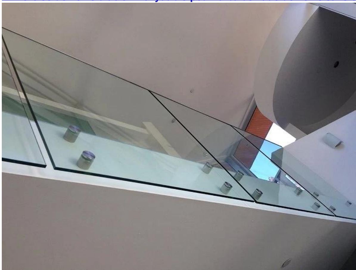
Entretoise de verre d'acier inoxydable pour la balustrade de verre sans cadre
