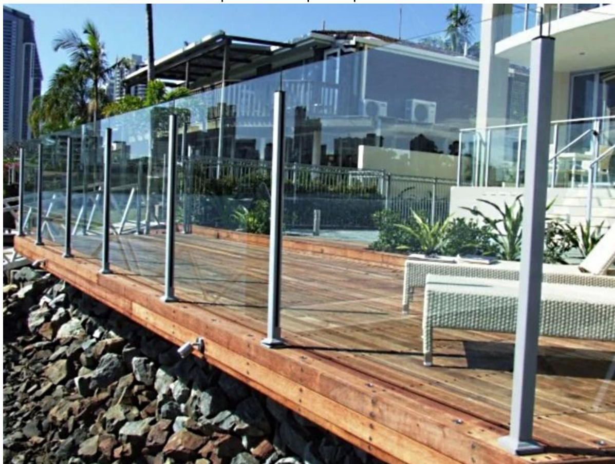
Main courante en aluminium pour la rampe de pont extérieure
