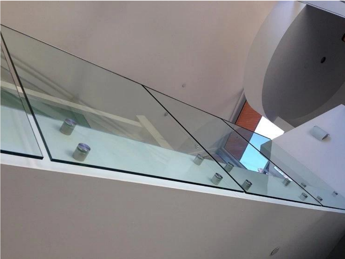
entretoise d'acier inoxydable, parenthèse pour des panneaux de verre, conception de balustrade
