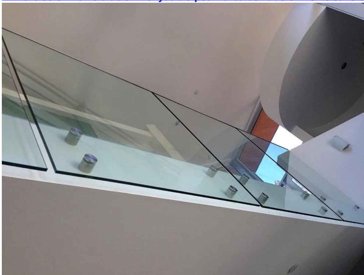
Entretoise en verre d'acier inoxydable pour la balustrade en verre sans cadre
