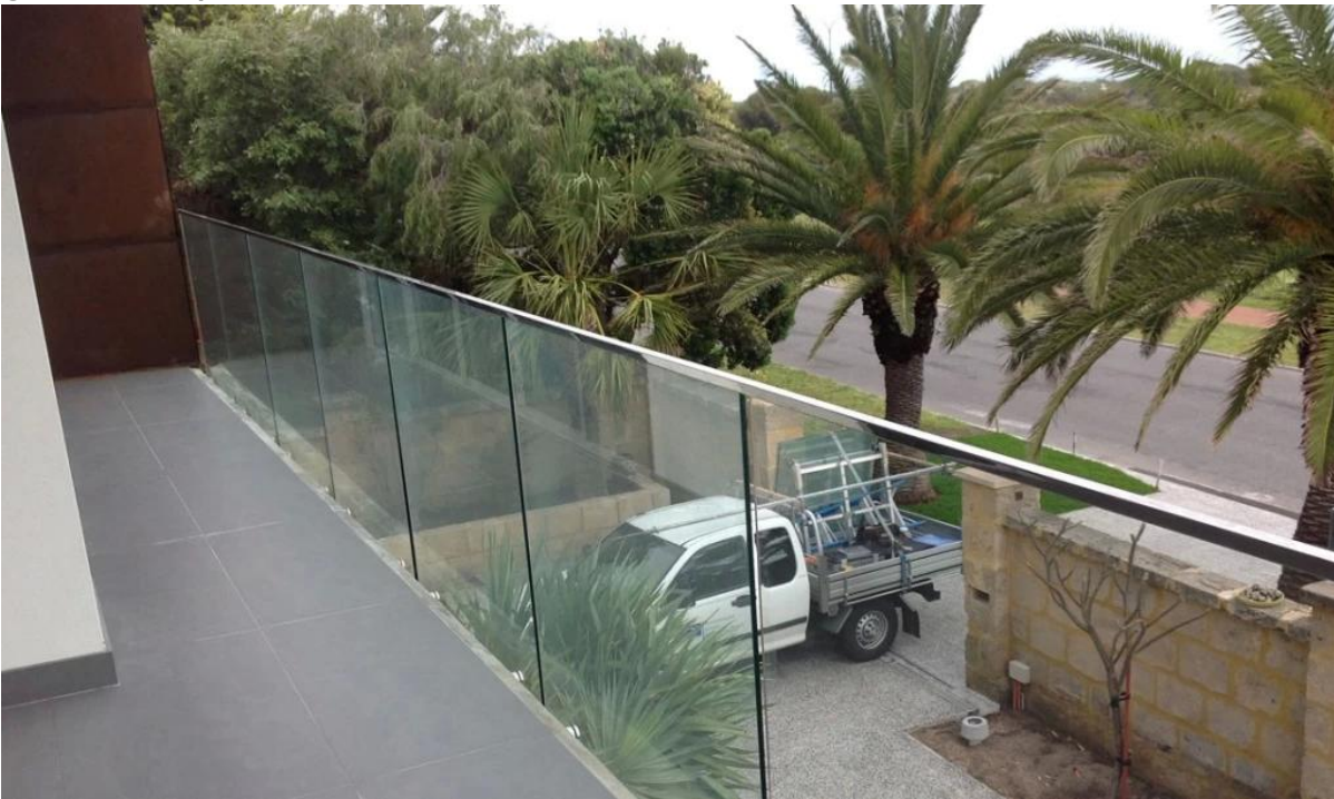
garde-corps en verre balcon
