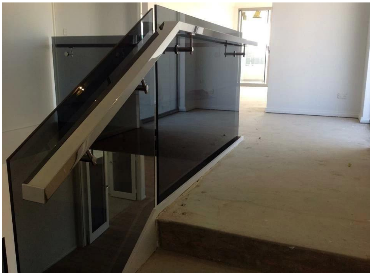
12 χιλιοστά γυαλί κιγκλίδωμα με κιγκλιδώματα από ανοξείδωτο χάλυβα
