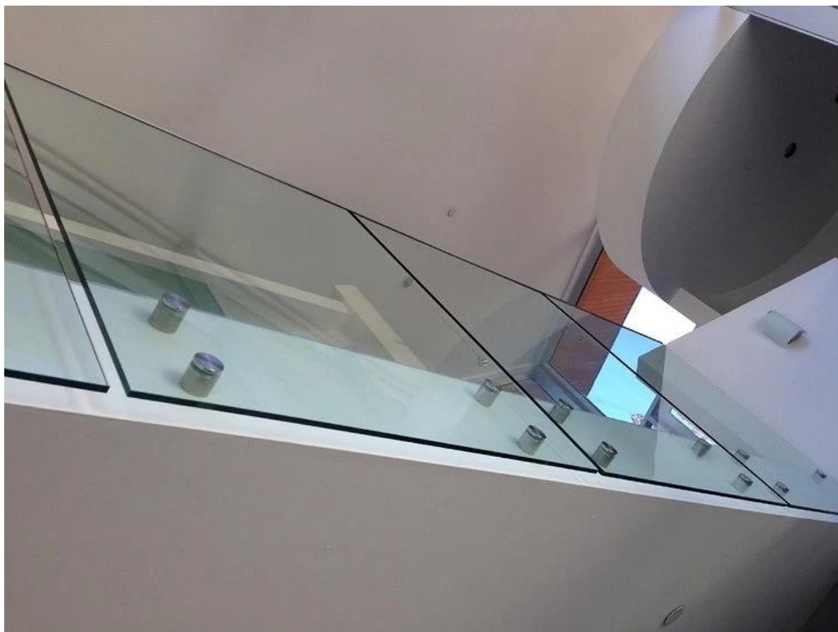
ανοξείδωτο χάλυβα standoff, βραχίονας για γυάλινες πλάκες, σχεδιασμό κιγκλιδώματος
