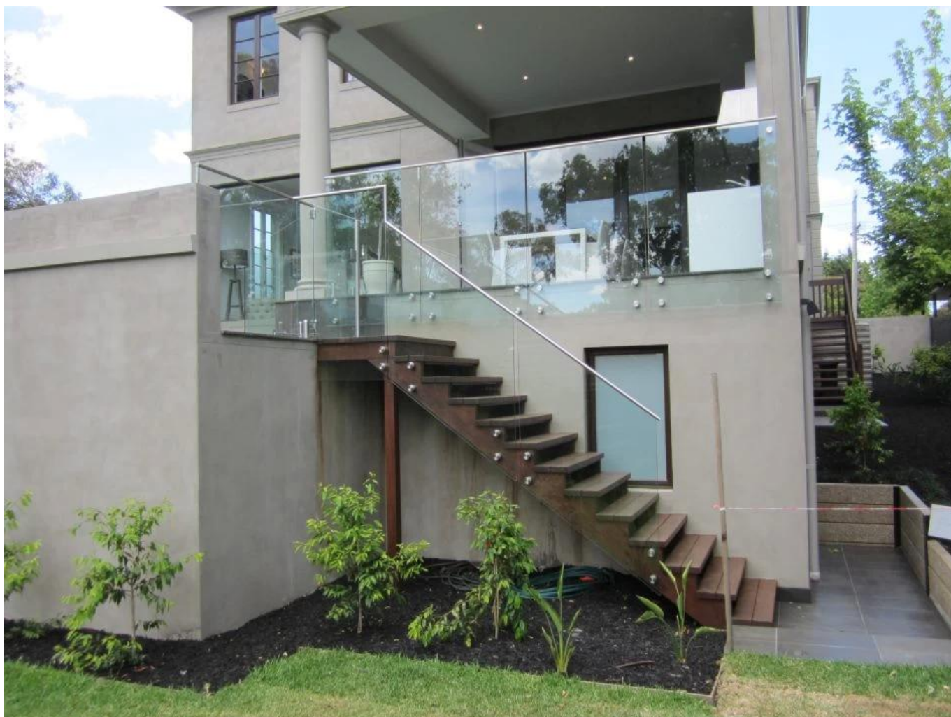
Ανοξείδωτο ατσάλι για ανάρτηση για γυάλινο κιγκλίδωμα χωρίς πλαίσιο
