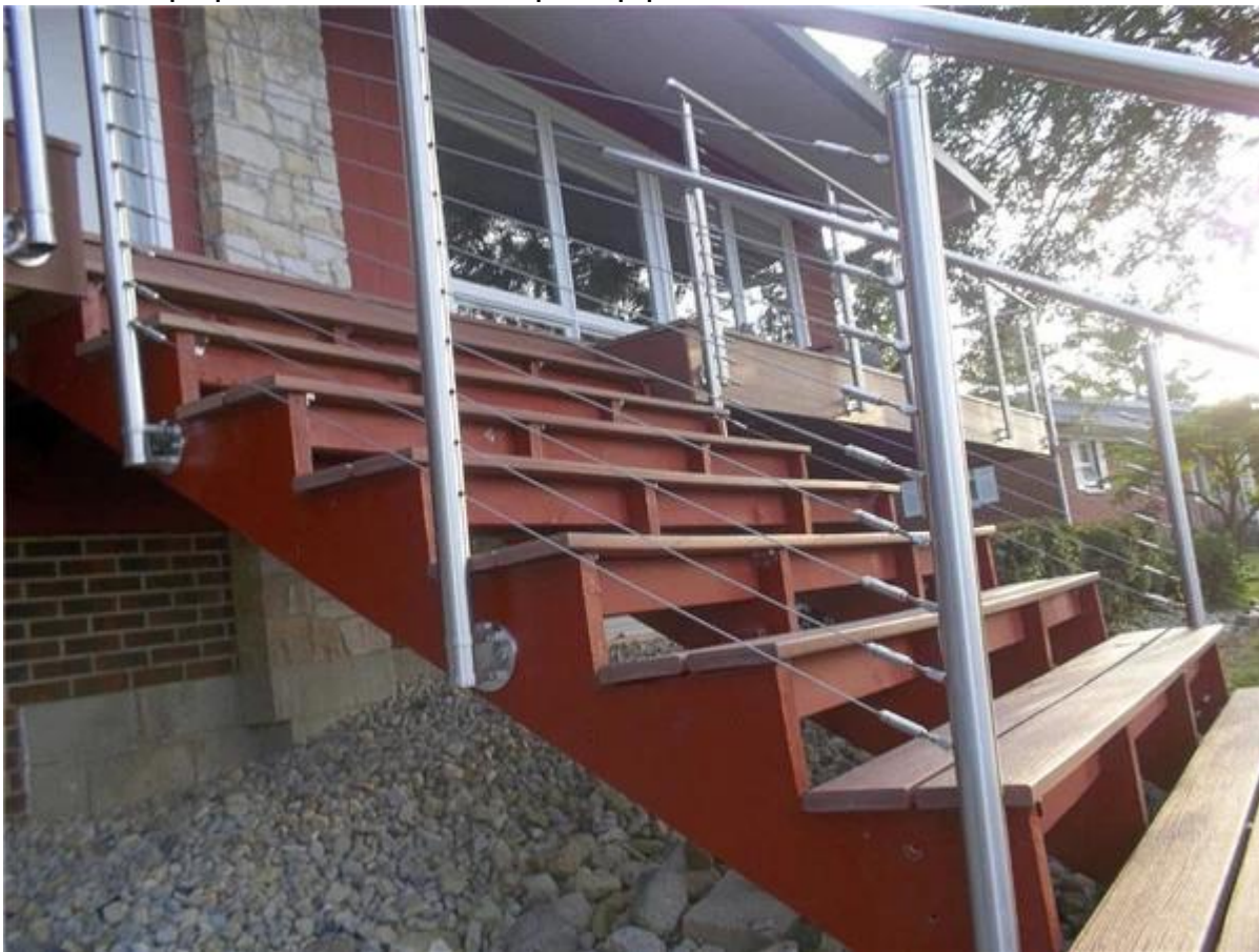
Τοποθέτηση καλωδίων T803 για έργα σκαλών
