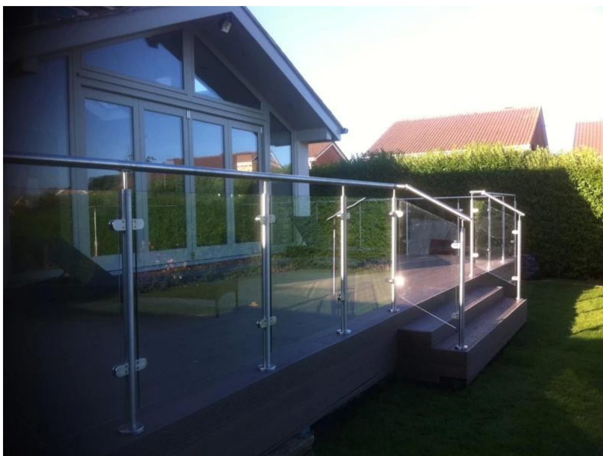
2) Ημι-πλαίσιο από ανοξείδωτο χάλυβα υπαίθρια κατάστρωμα γυαλί σχεδιασμό κάγκελο,
