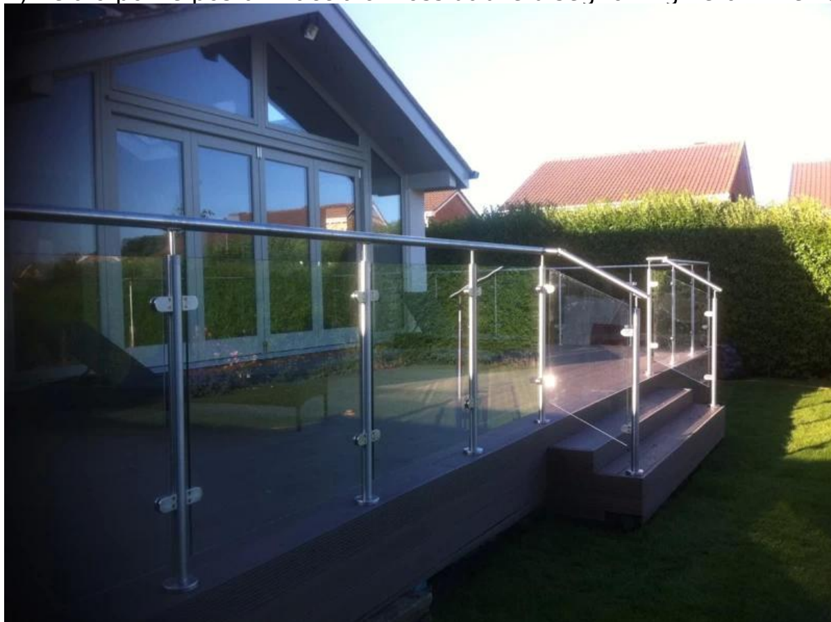
3) Semi-frame ponte posta in acciaio inossidabile disegno ringhiera in vetro,
