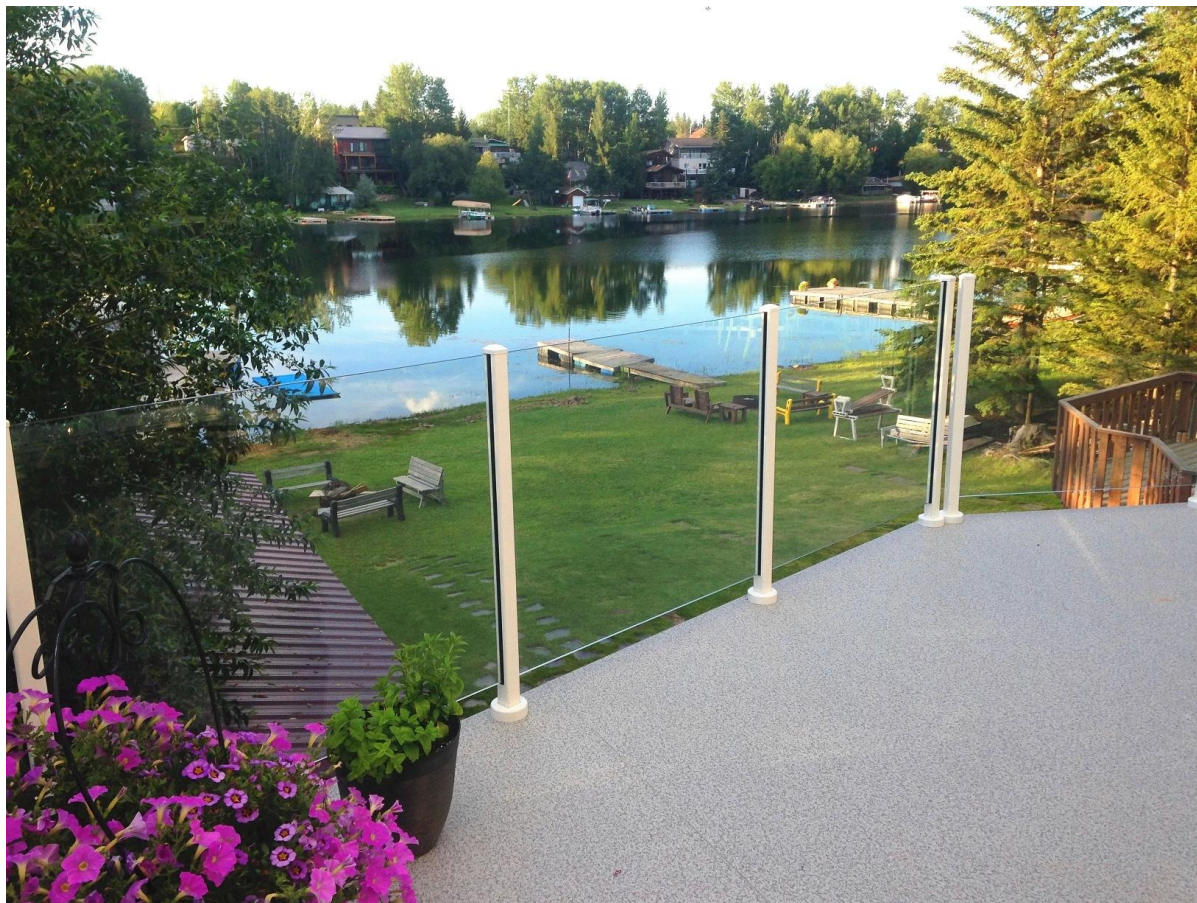
2) rotonda semi colonna in alluminio di recinzione di vetro frameless : 50 mm di diametro x 3 mm
