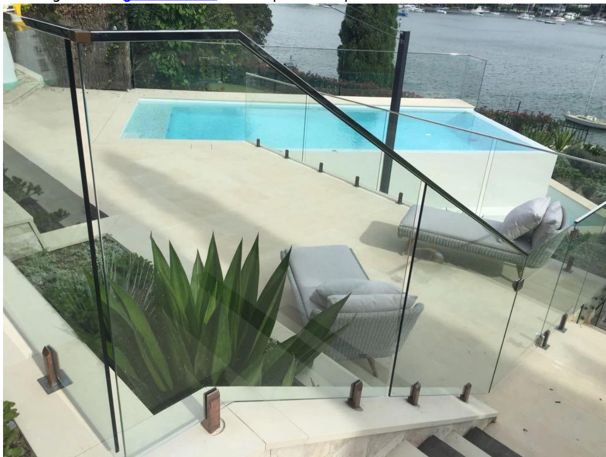
Leuning GLB en glazen kraan ontwerp voor trap
