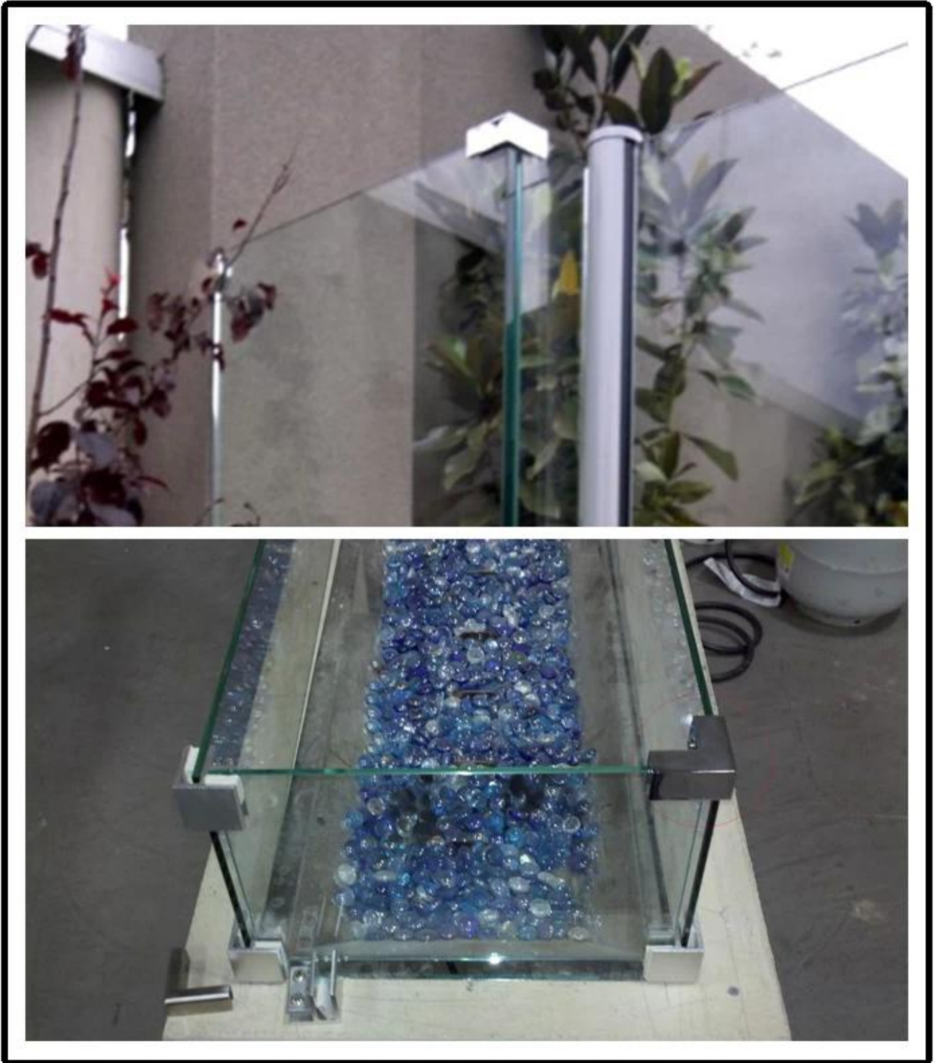
Verschillende soorten glasklemmen met afmetingen:
