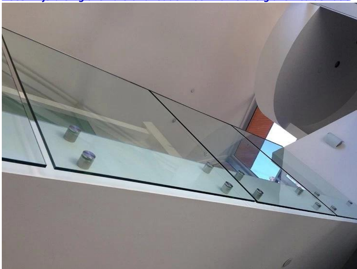
Roestvrijstalen glazen afstandhouder voor frameleze glazen balustrade
