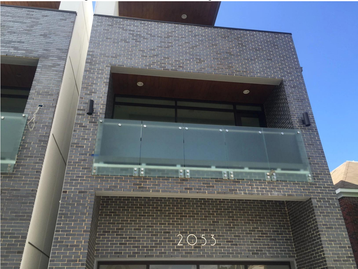
Installatie foto's van glazen balustrade standoff beugel
