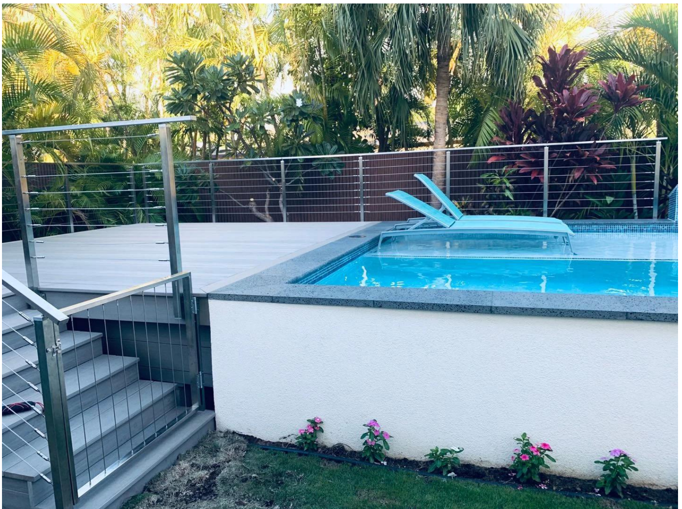
kabelbevestigingspalen aan de zijkant -
