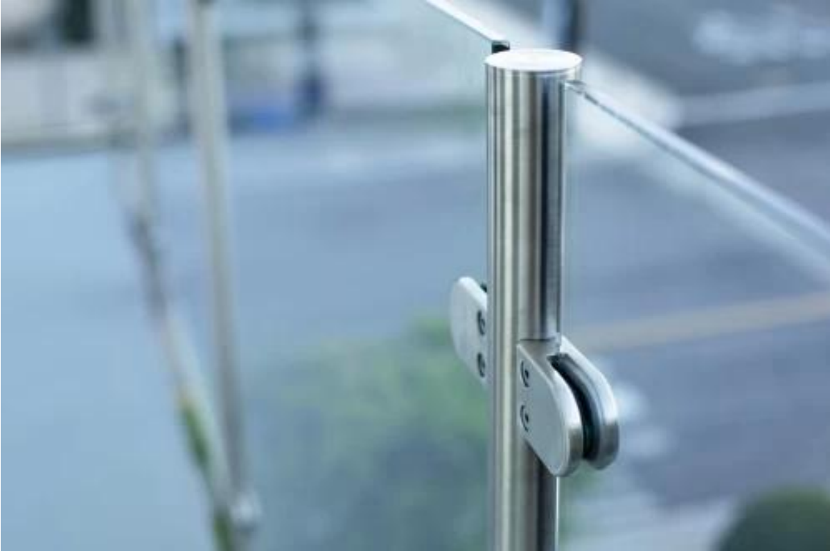
Close-upfoto's van leuningbevestiging glazen klem satijn & spiegelafwerking -
