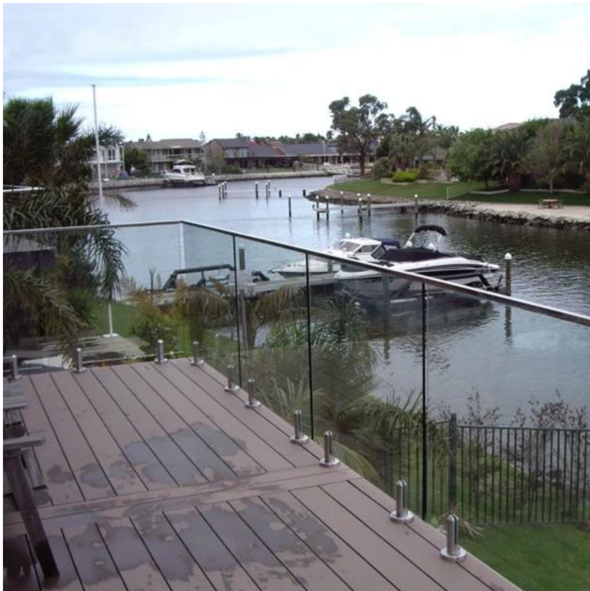
Kwadratowe rury poręczy i Czop kwadratowy szkła na pokładzie szkło poręcze
