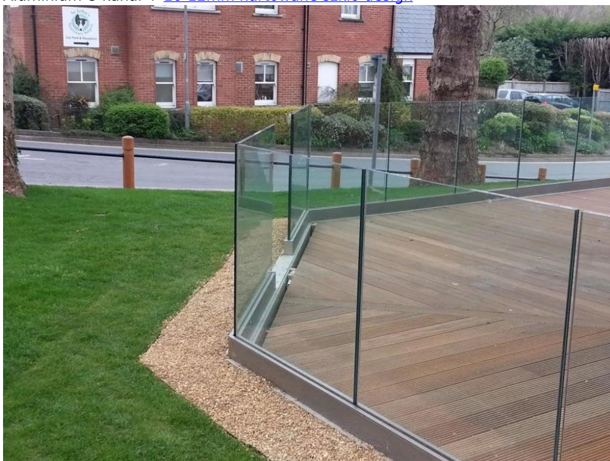
Aluminium U kanał + 10-12mm hartowane szkło design
