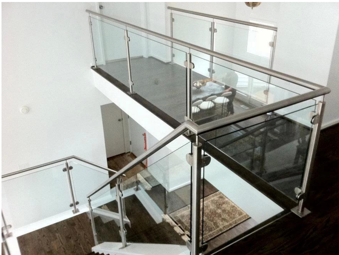
balustrady balkonu po za ramy szklane balustrady
