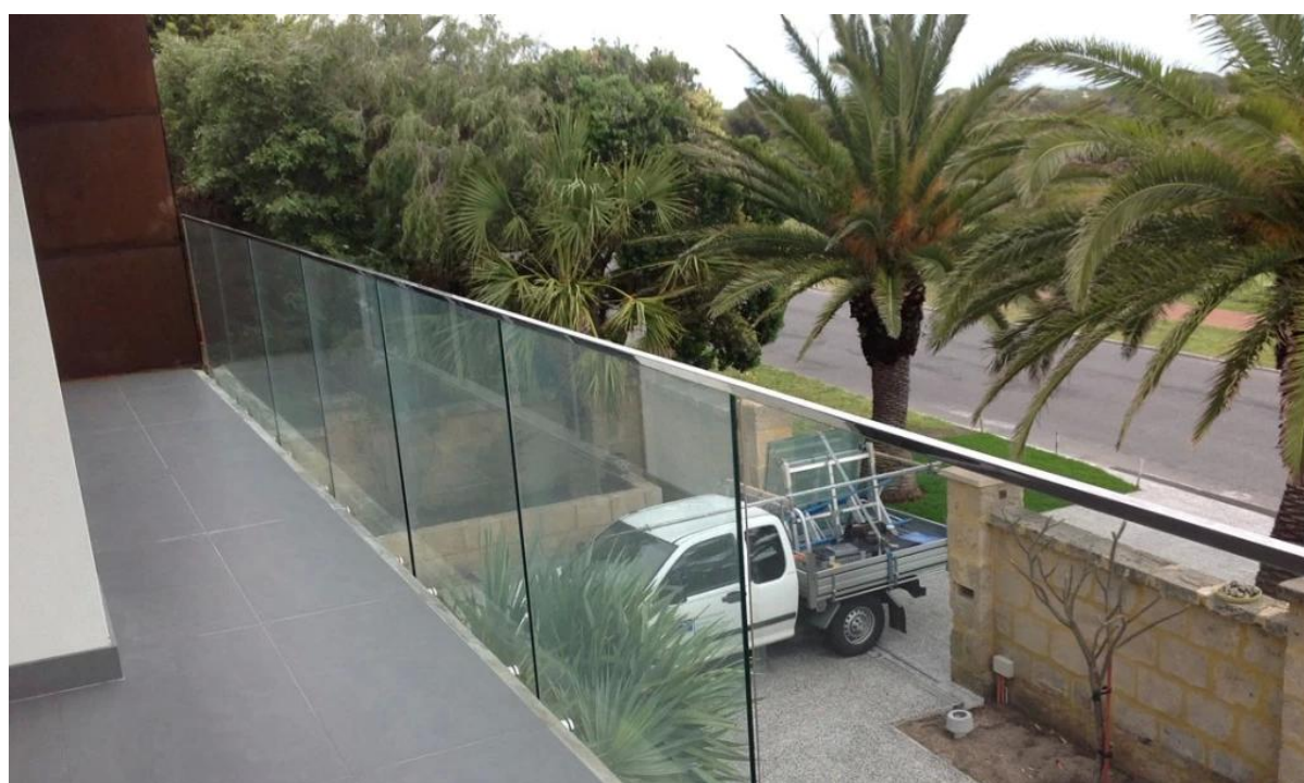
2. szklana balustrada zamontowana poręcz górna Uchwyt mini zatykania
