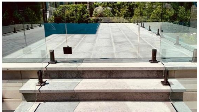
Satin Brushed Braçadeira de vidro de ponta de aço inoxidável para guarda-corpo de vidro sem moldura SBM-3:
