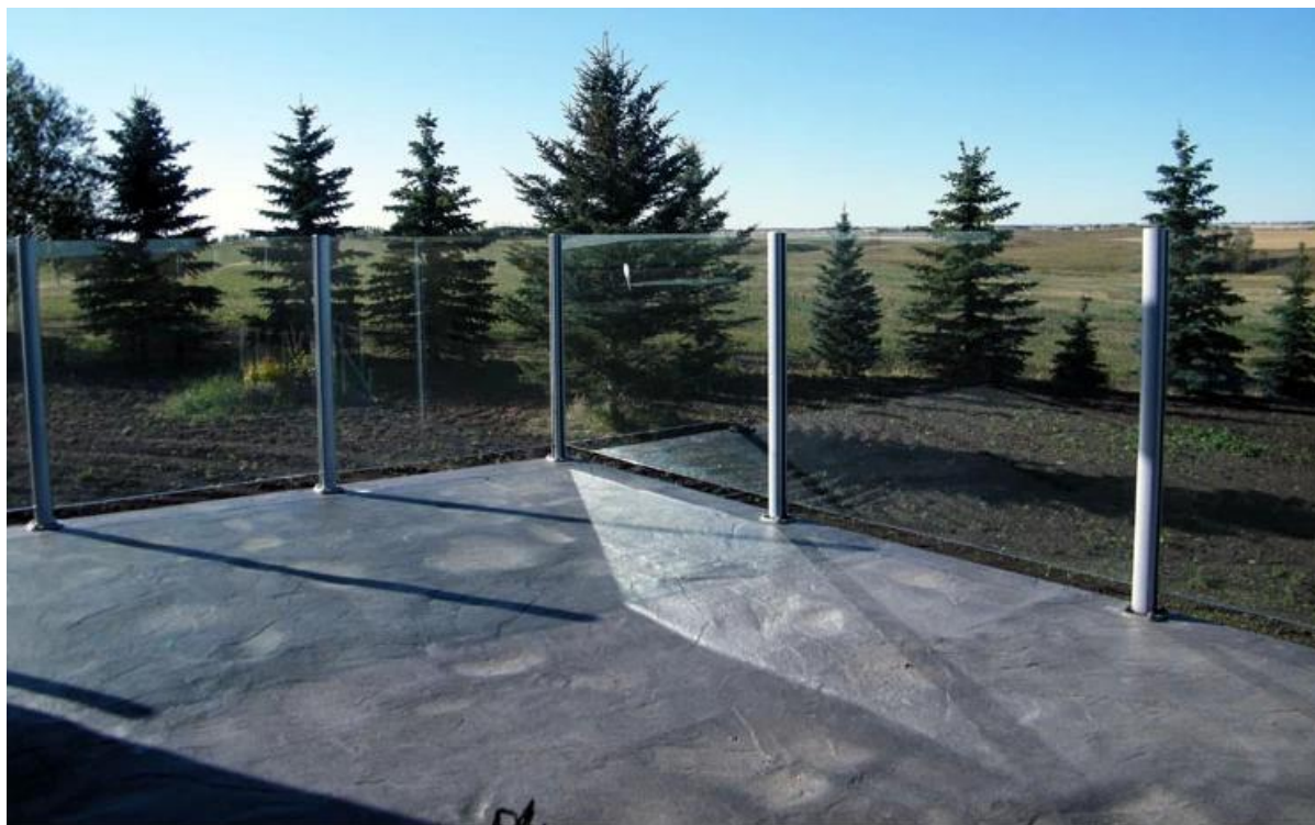
Corrimão de alumínio balcão no Canadá
