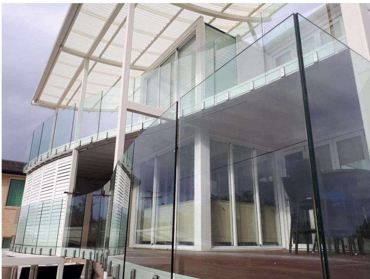
**Empacotamento de vidro esperto montado cara dos spigots da parede lateral**
