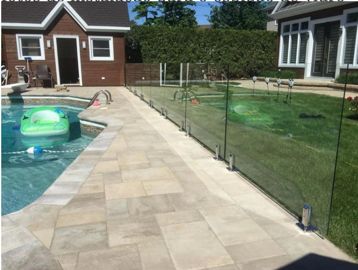
fotos de instalação para o espigão de vidro
