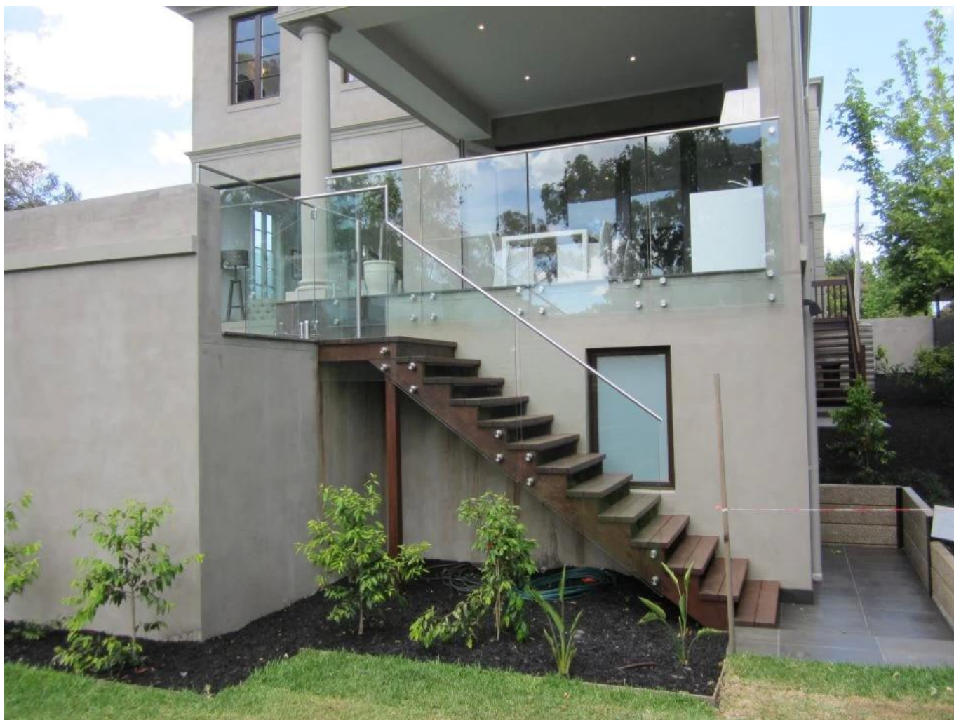
Стойка из нержавеющей стали для бескаркасной стеклянной балюстрады
