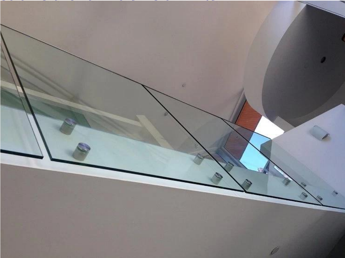
الفولاذ المقاوم للصدا المواجهة، قوس للألواح الزجاجية، تصميم حديدي
