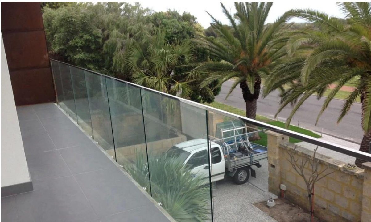
الزجاج حديدي شنت أعلى درابزين قوس صغير متوجا تفاصيل السكك الحديدية .2
