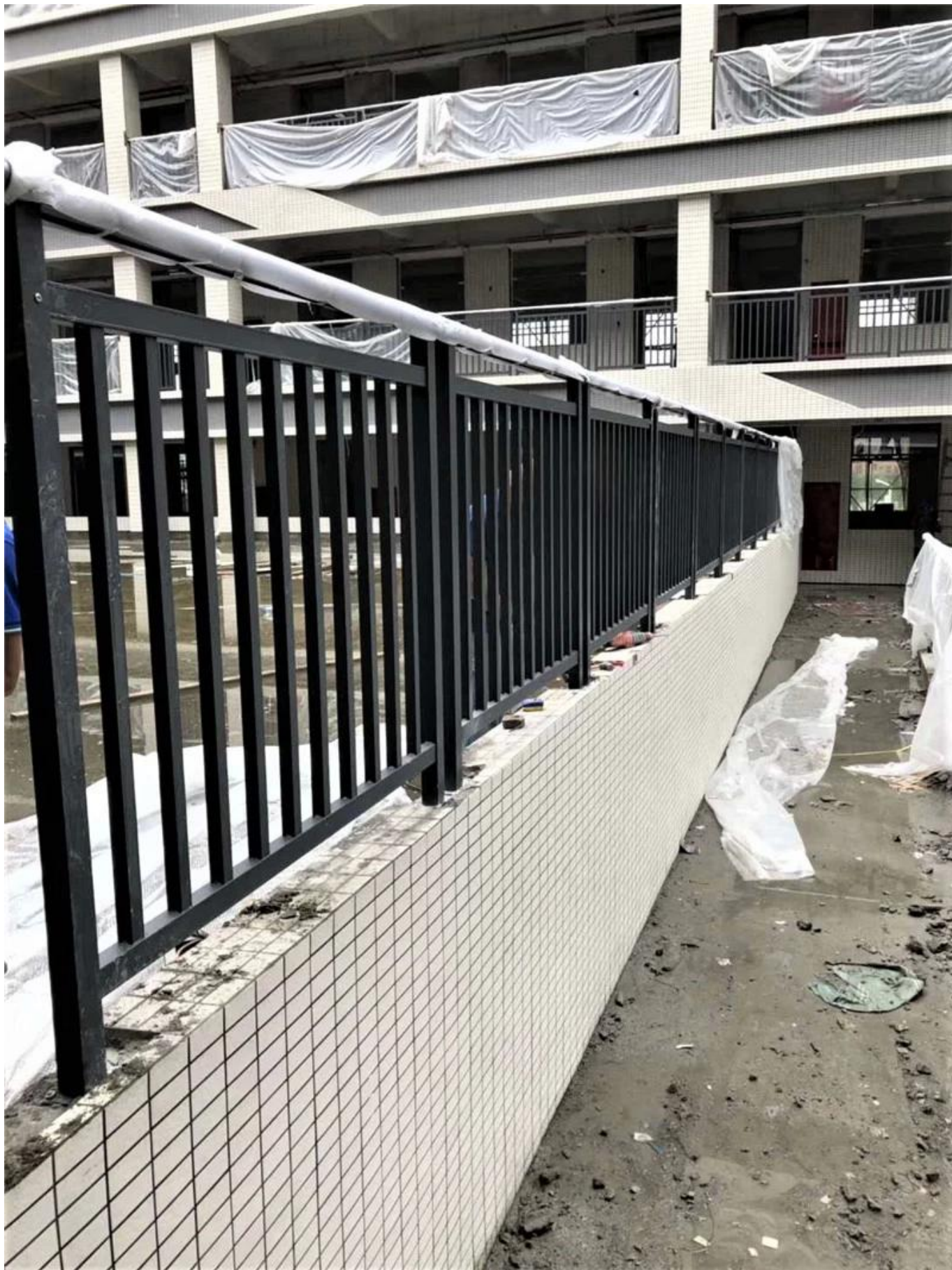
圖 1 展示了本計畫所屬之建築工程現場，圖中可見正在施工的圍牆及欄杆，並有白色塑膠布覆蓋部分區域。
