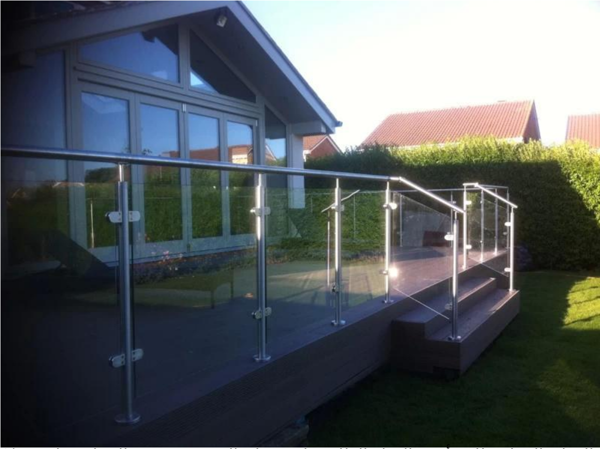
شبه الإطار الفولاذ المقاوم للصدأ في الهواء الطلق، على سطح السفينة تصميم الزجاج درابزين، (2)
