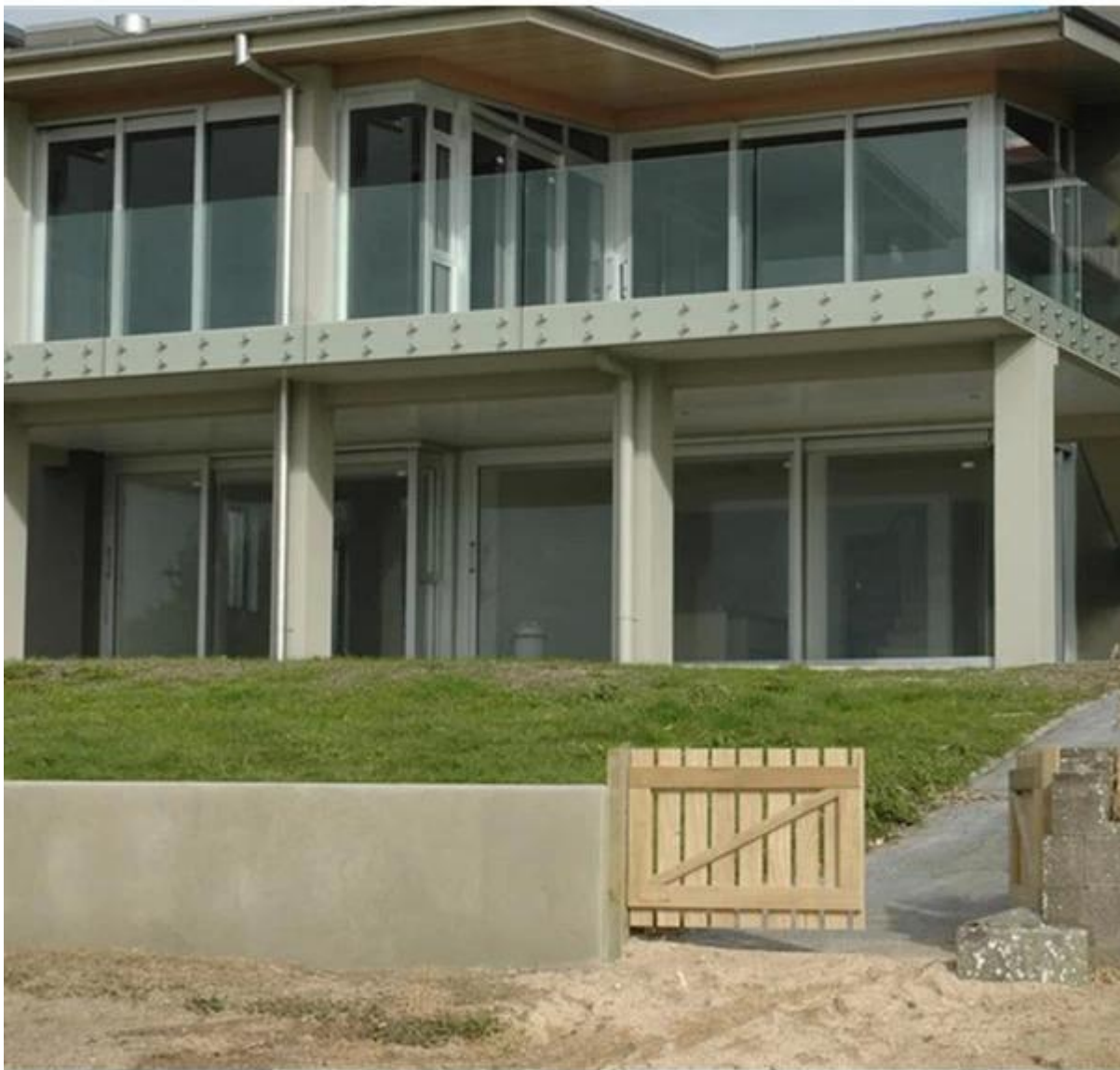
Standoff Halter auf Holz Balkone verwendet:
