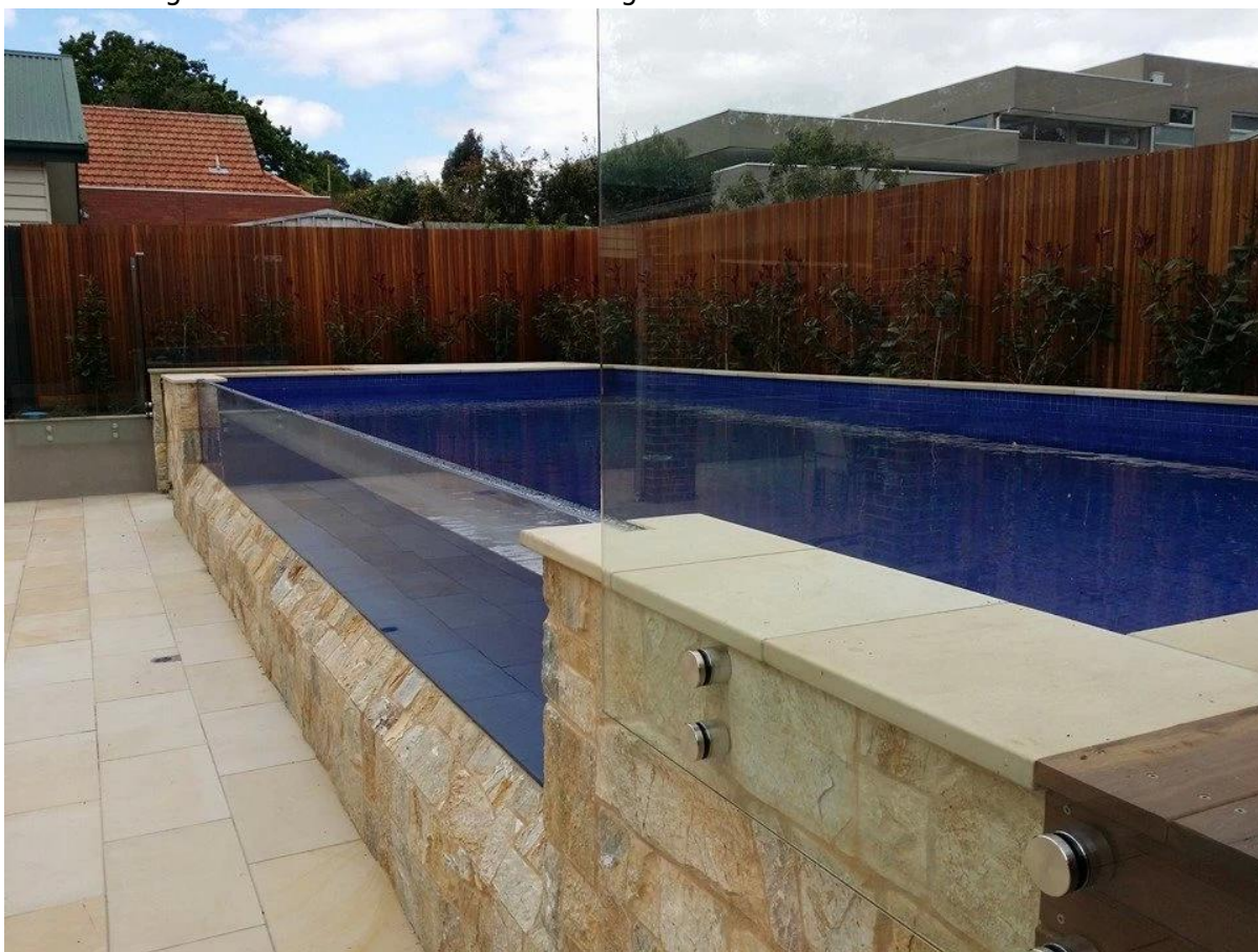
Standoff angewendet auf Schwimmbad Glasgeländer:
