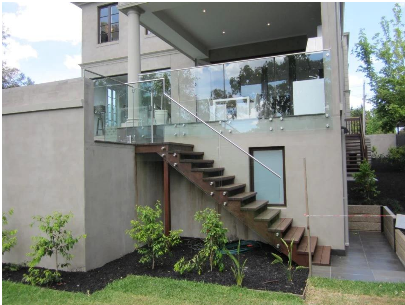
Abstandhalter aus Edelstahlglas für rahmenlose Glasbalustraden
