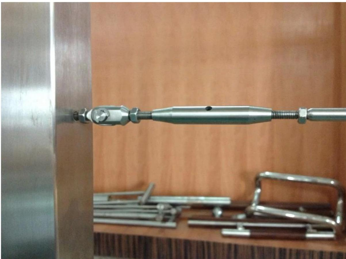
**T804 Drahtseilspanner an Stahl befestigt -**
