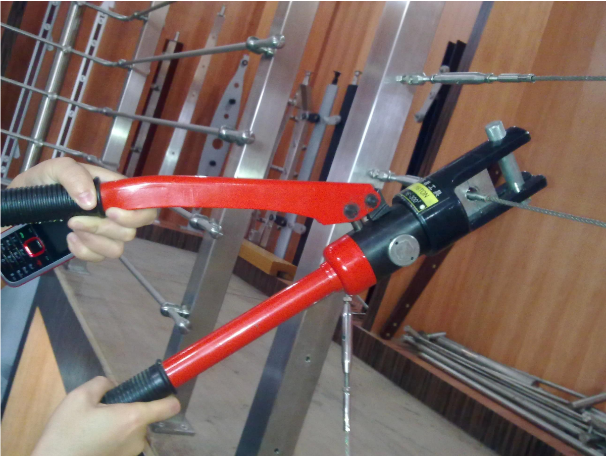
nach der Installation:
