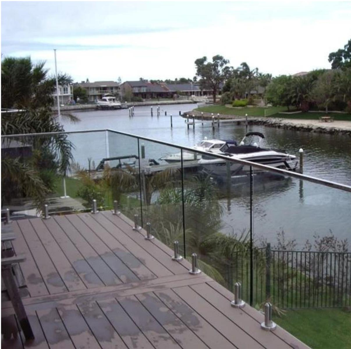
Handlauf Rohr quadratisch und [quadratische Glas Zapfen](#) für Deck-Glasgeländer
